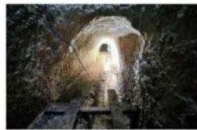
Cette portion est le début de la partie souterraine de l'aqueduc, au valon des Arcs...
