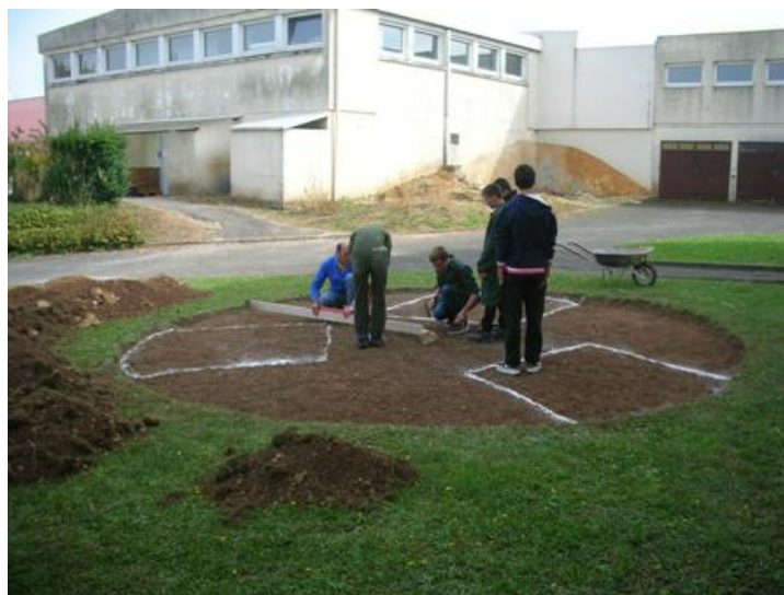
Terrassement et positionnement des tables bancs.
