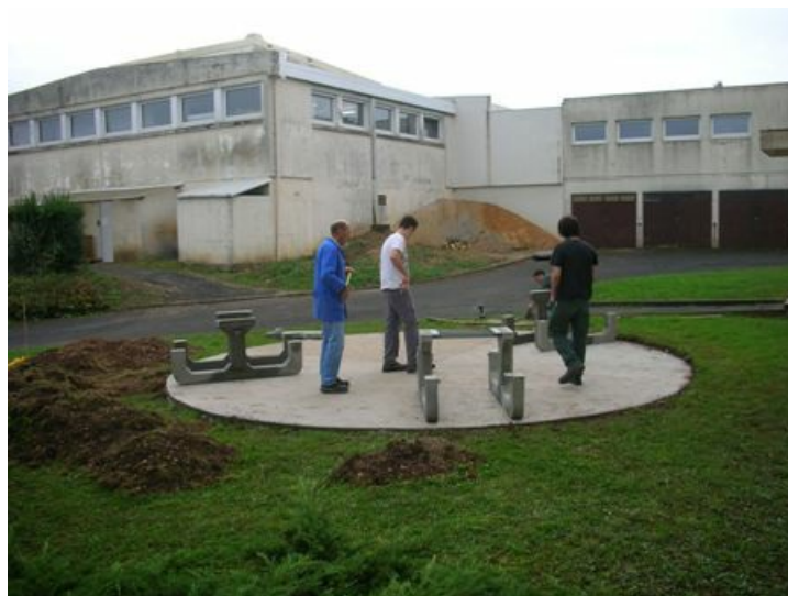
La pose du mobilier.
