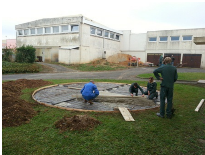
On commence à couler la chape.
