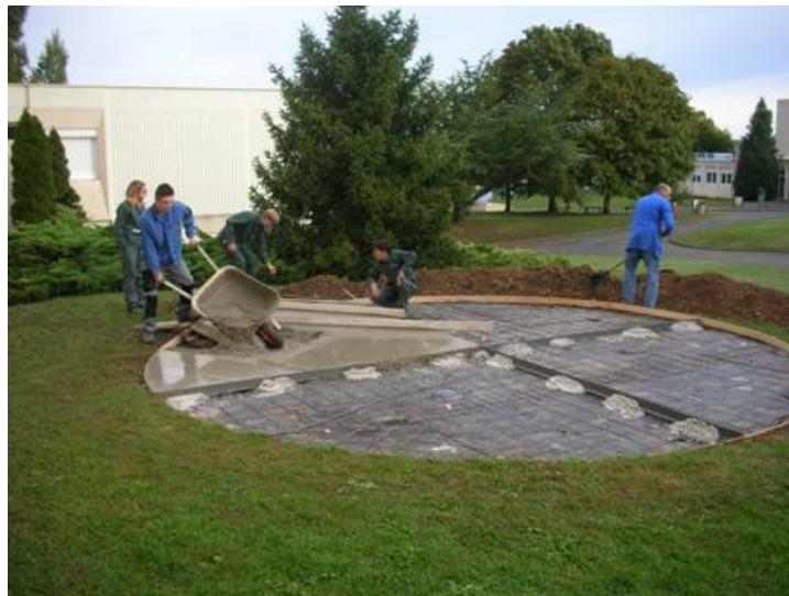
Coulage de la chape.
