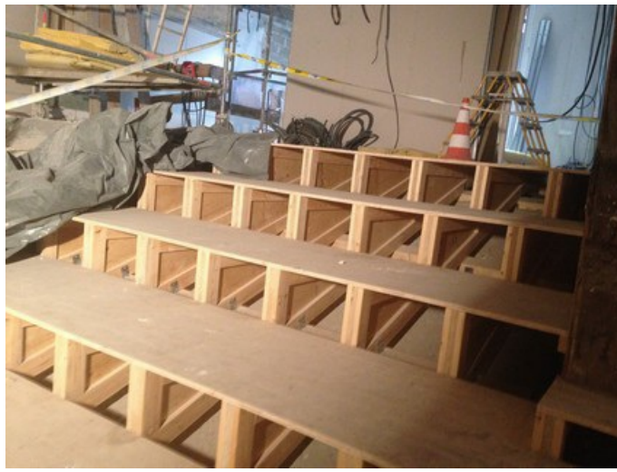
Gradins de la future salle de spectacle
