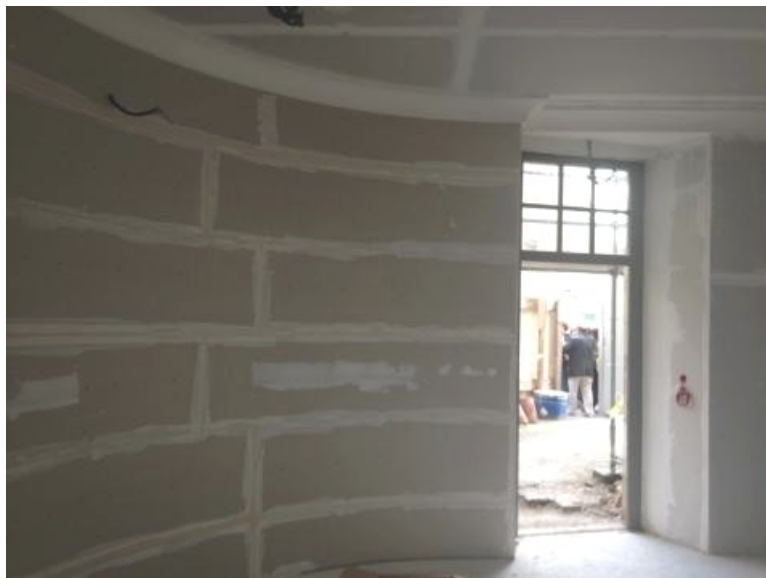
Salle en rénovation
