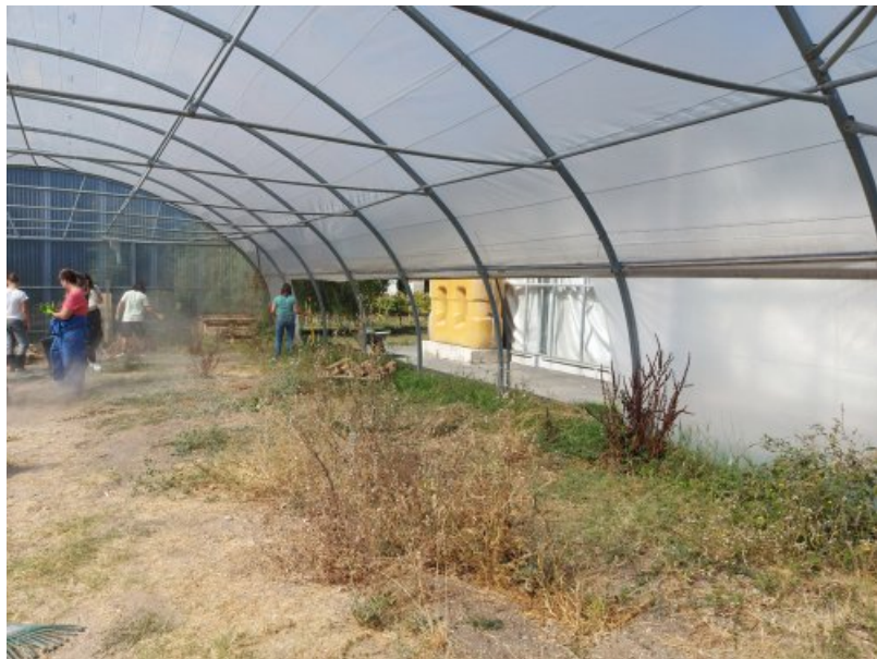
La serre -tunnel au début des travaux
