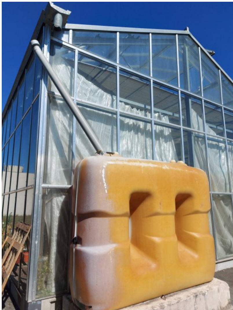
Le récupérateur d'eau de pluie
