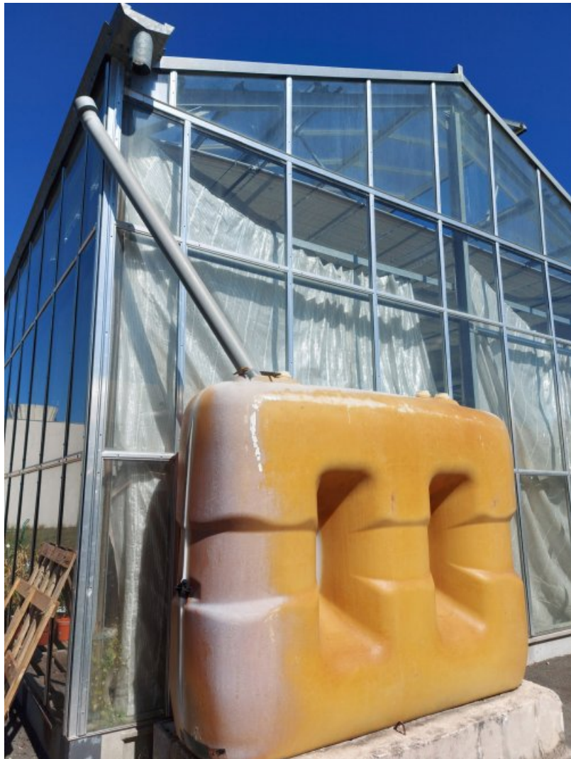
Le récupérateur d'eau de pluie
