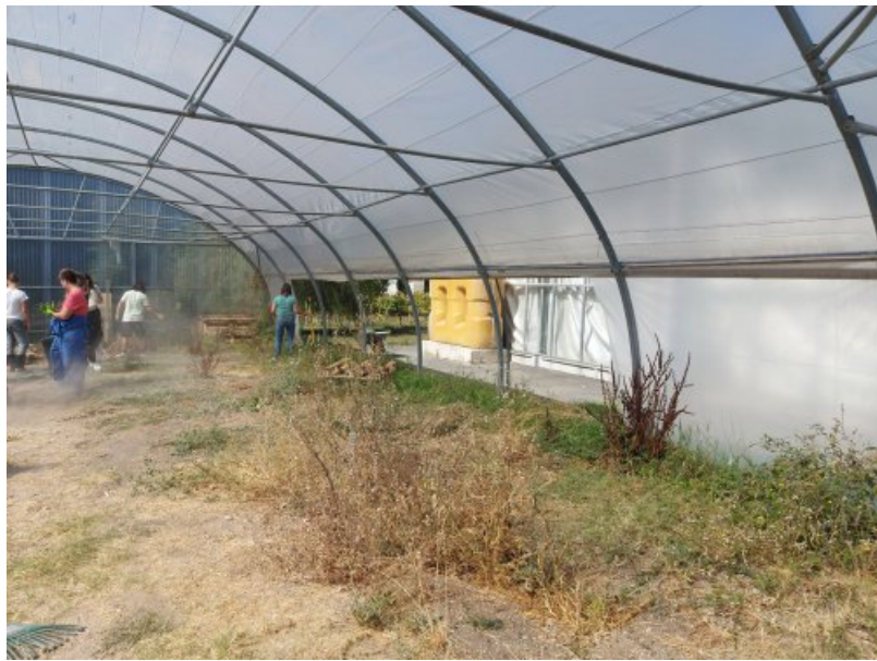
La serre -tunnel au début des travaux
