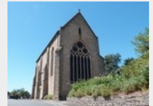
© Chapelle des Cordeliers Source : CC de Parthenay
