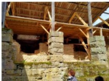
Four pour chauffer les Thermes
