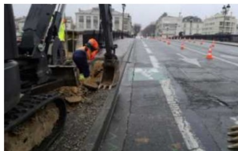
Les travaux devraient durer jusqu'à mardi ou mercredi sur le pont Palissy. PHOTO PH.M.
