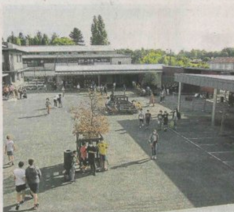
La cour du collège Henri-Martineau a, cet été, été dotée de préaux.
