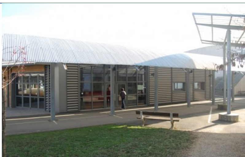
Le bâtiment de la MDL, vu de l'extérieur.
