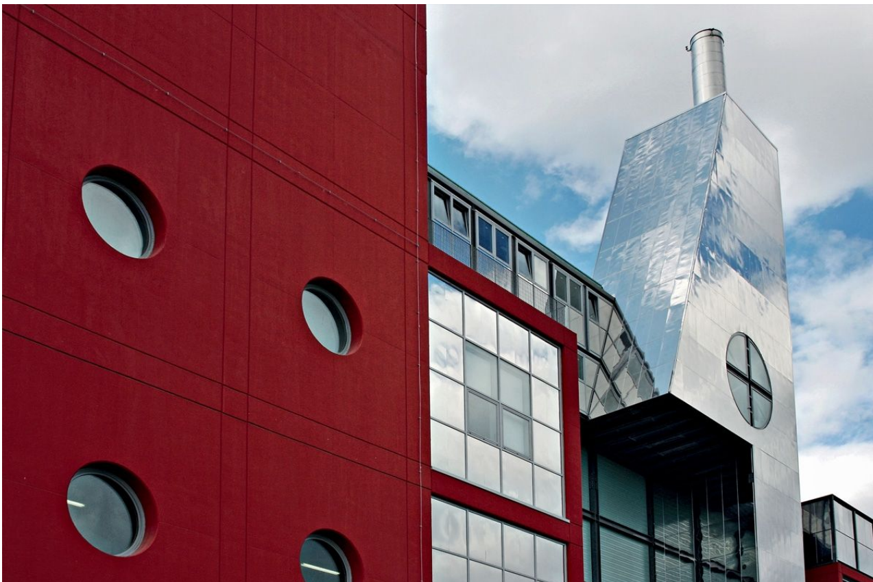
Termovalorizzatore di Forlì
