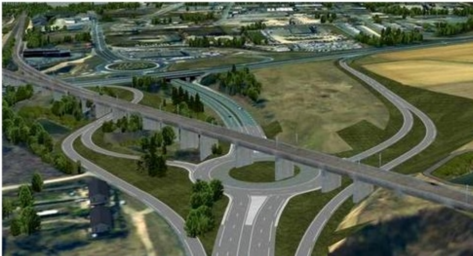
Un rond-point sera aménagé sur la RD 910 (ex-RN 10) sur lequel seront plantés deux piliers de la future « estacade » longue de 1,3 km qui passera ensuite sous la RN 147 avant de filer vers Poitiers. - (dr)
